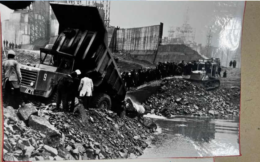
Перекриття старого русла.
